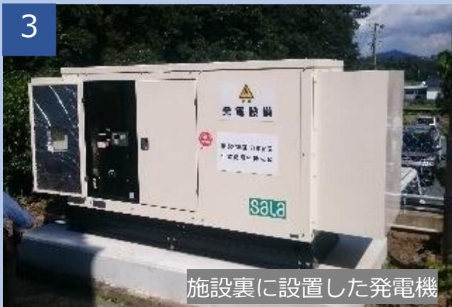
近隣に配慮し排気フードで排気方向を限定
